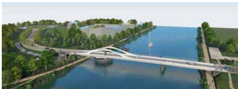
Vétuste et trop souvent en panne, le pont de Colombelles va être remplacé. Il a été décidé de construire un nouvel ouvrage mobile légèrement en aval du pont existant. Après d'importants travaux en 2008, une inspection détaillée en 2016 avait mis en évidence une fatigue d'éléments structurels de la charpente métallique. Depuis, Ports de Normandie intervient régulièrement pour des réparations devenues coûteuses. Le Département soutiendra financièrement cette opération.
