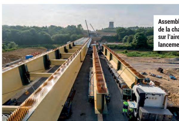
Assemblage de la charpente sur l'aire de lancement.
